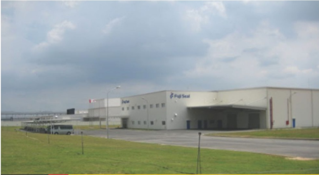
FUJI SEAL PROJECT PHASE 2 (VSIP II EXPAND) DỰ ÁN FUJI SEAL GIAI ĐOẠN 2 (VSIP II MỞ RỘNG)
