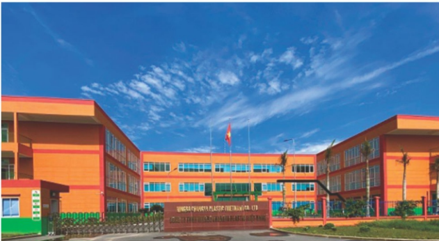
CHANGYA PLASTIC FACTORY - TÂY NINH NHÀ MÁY CHANGYA PLASTIC - TÂY NINH
